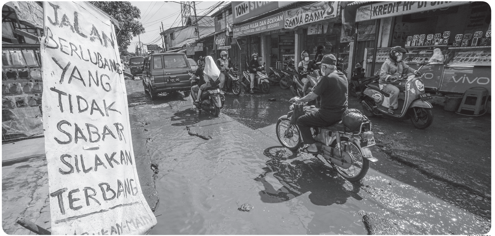
JALAN RUSAK DI KABUPATEN BOGOR
